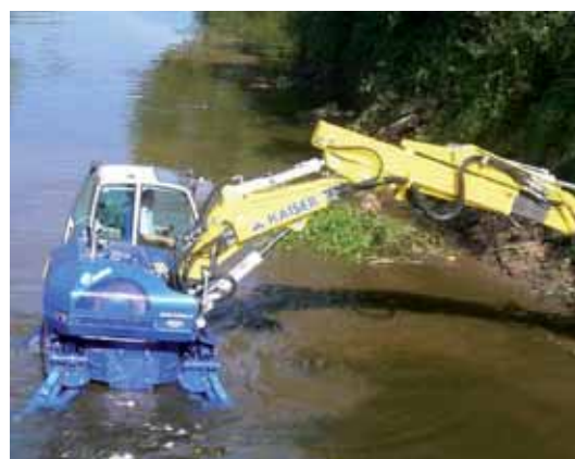
Ausbaggern des Unterwassers
