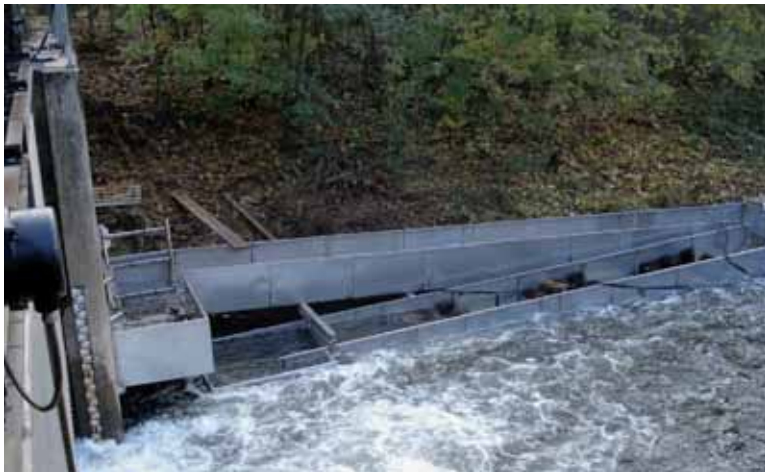
Montierte Edelstahlrinne am Fischpaß
